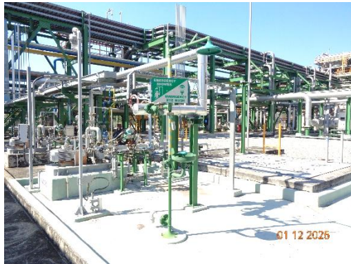
รูปที่ 3.45 อ่างล้างตาและร่างกายในบริเวณกระบวนการผลิต
