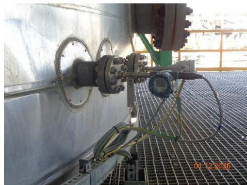
อุปกรณ์วัดอุณหภูมิถึงปฏิกิริยาฟิสิกส์ออกซิเดชั่น
