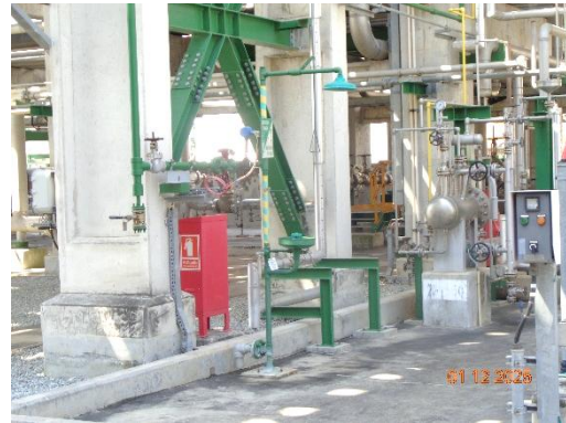
รูปที่ 3.45 อ่างล้างตาและร่างกายในบริเวณกระบวนการผลิต
