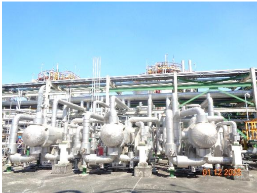
รูปที่ 3.58 ฉนวนหุ้มอุปกรณ์การผลิตที่เกี่ยวข้องกับโพธิ์สินออกไซด์
