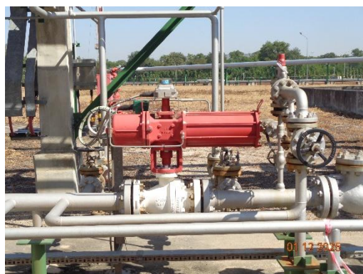
รูปที่ 3.57 อุปกรณ์ความปลอดภัยต่างๆ เช่น Safety Valve (Relief & Vacuum Valve), Shut Off Valve และ Reactor High Pressure Control Valve
