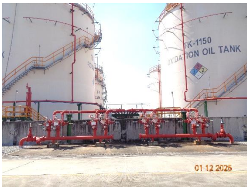
รูปที่ 3.42 ระบบน้ำฉีด (Water Spray) รอบผนังและหลังคาถังเก็บกัก
