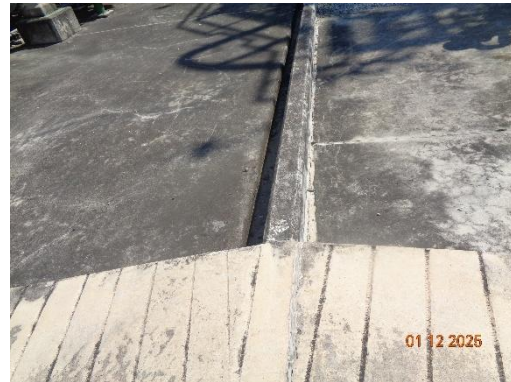
รูปที่ 3.59 คันกันล้นรอบบริเวณบ่มสุบโพธิ์สินออกไซด์
