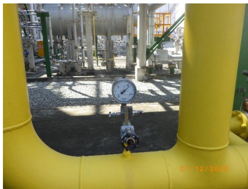
รูปที่ 3.55 Pressure / Temperature Indicator
