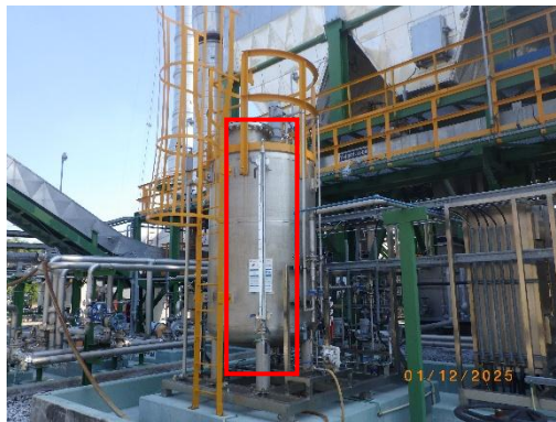
รูปที่ 3.52 Level Indicator ที่ถังเก็บกาก
