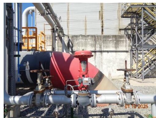
รูปที่ 3.57 อุปกรณ์ความปลอดภัยต่างๆ เช่น Safety Valve (Relief & Vacuum Valve), Shut Off Valve และ Reactor High Pressure Control Valve
