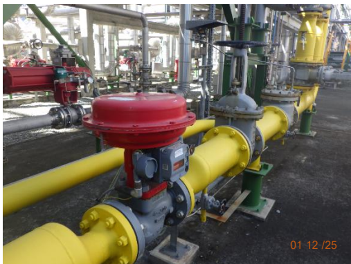
รูปที่ 3.60 อุปกรณ์ป้องกันการไหลกลับ (Back Flow Prevention Device)
