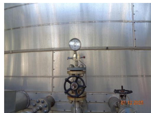
รูปที่ 3.61 อุปกรณ์วัดอุณหภูมิ และระดับของเหลวในถังเก็บโพธิ์สินออกไซด์
