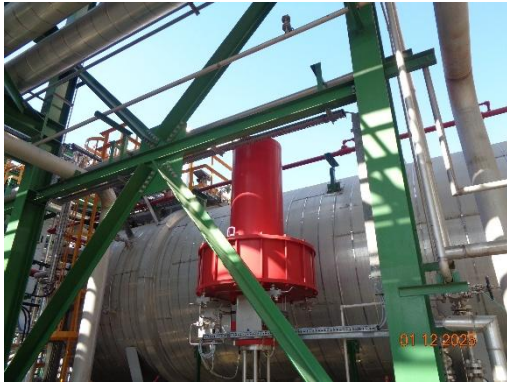
รูปที่ 3.57 อุปกรณ์ความปลอดภัยต่างๆ เช่น Safety Valve (Relief & Vacuum Valve), Shut Off Valve และ Reactor High Pressure Control Valve (ต่อ)
