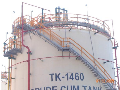
รูปที่ 3.42 ระบบน้ำฉีด (Water Spray) รอบผนังและหลังคาถังเก็บกัก (ต่อ)
