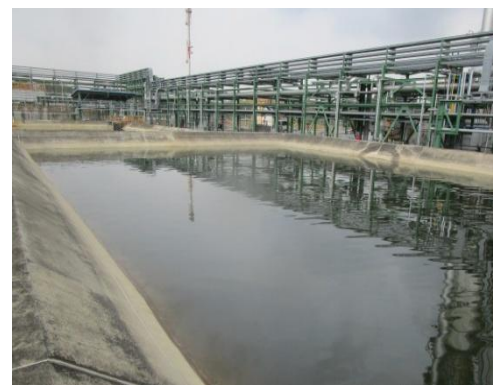
บ่อตรวจสอบคุณภาพน้ำระบายทิ้งจากหอหล่อเย็น (Cooling Water Blowdown Check Basin)
