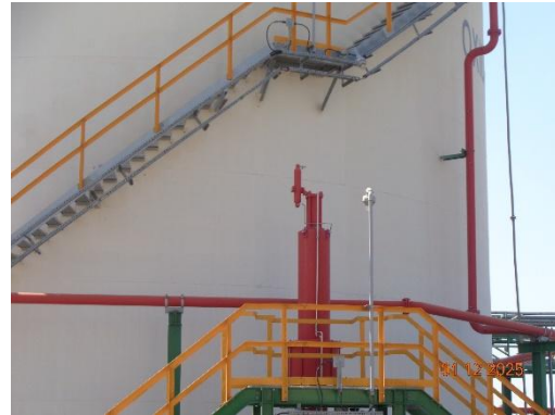
รูปที่ 3.57 อุปกรณ์ความปลอดภัยต่างๆ เช่น Safety Valve (Relief & Vacuum Valve), Shut Off Valve และ Reactor High Pressure Control Valve (ต่อ)
