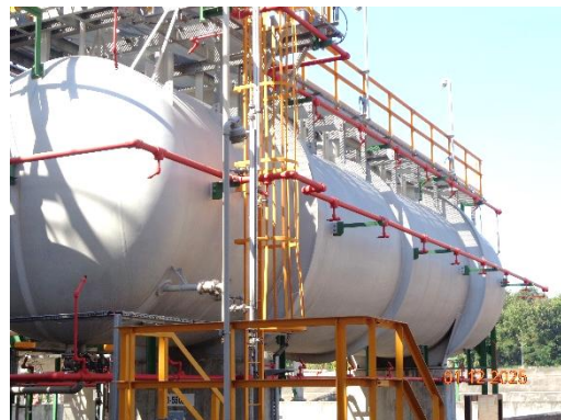
รูปที่ 3.42 ระบบน้ำฉีด (Water Spray) รอบผนังและหลังคาถังเก็บกัก
