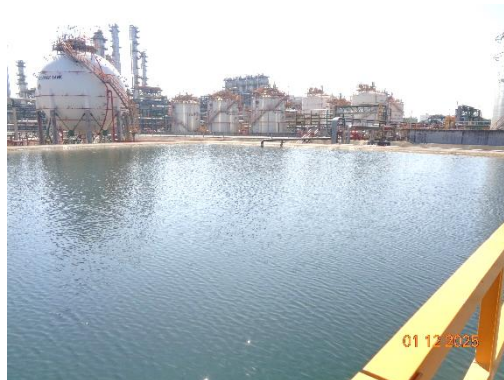
รูปที่ 3.50 บ่อน้ำสำรองดับเพลิง
